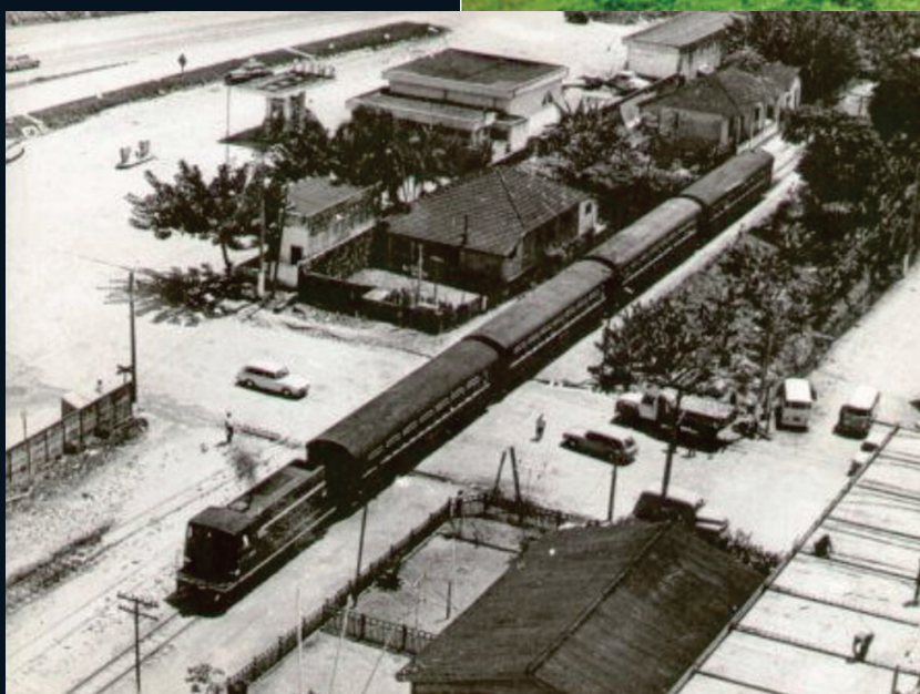
Imagem acima à direita: Trecho de Itanhaém; último trem de passageiros em 1997. Imagem abaixo à esquerda: Trecho de Mongaguá; trem de passageiros em 1960.
