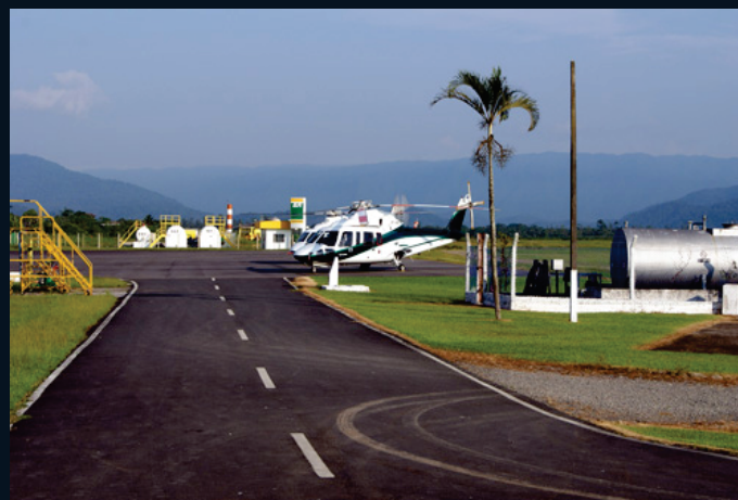
Imagem superior: Entrada do Aeroporto Antonio Ribeiro Nogueira Jr. (recepção) Imagem inferior: Visão da entrada lateral, que dá acesso aos postos de combustíveis das aeronaves
